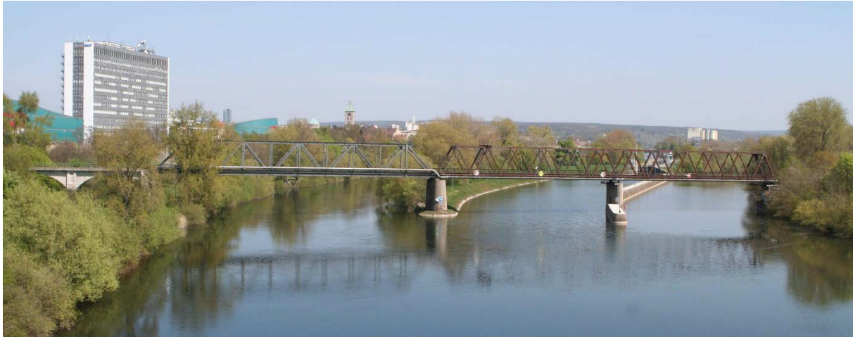
Mainbrücke in Schweinfurt
